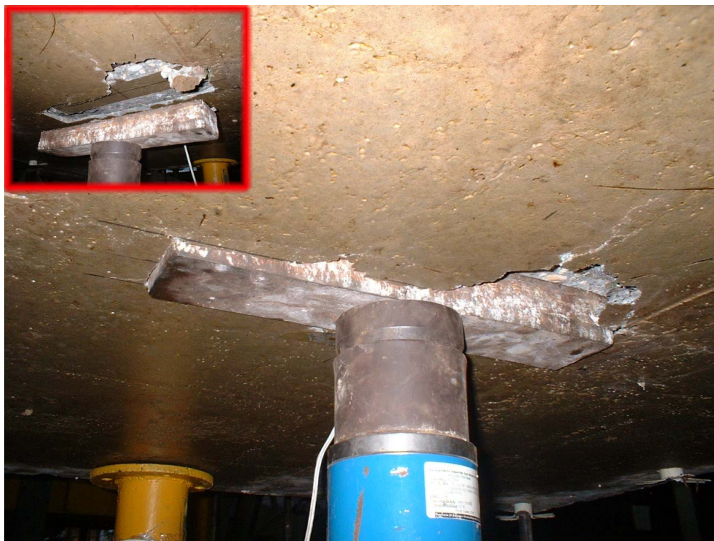
Figura 6.86 - Face inferior da laje L6 após o ensaio
