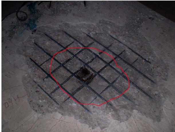
a) Laje L1
