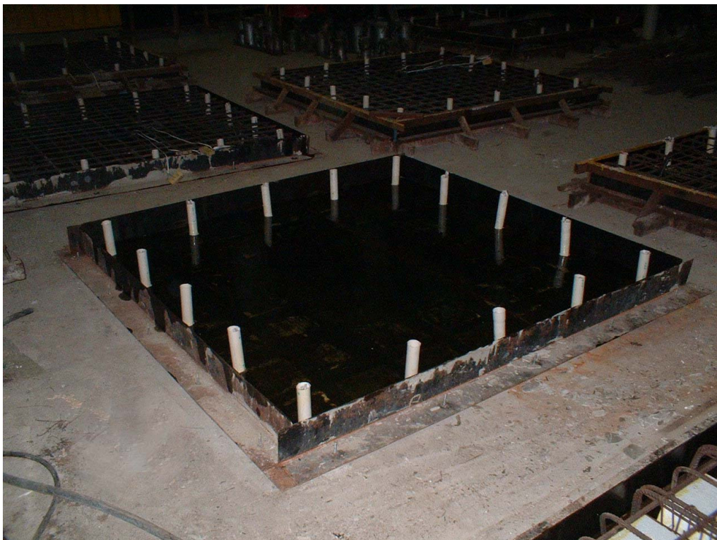
Figura 3.31 - Esquema das fôrmas metálicas
