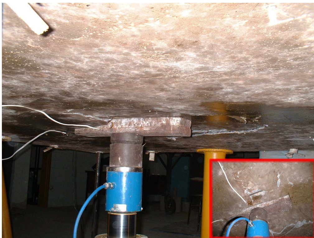
Figura 6.90 - Face inferior da laje L8 após o ensaio
