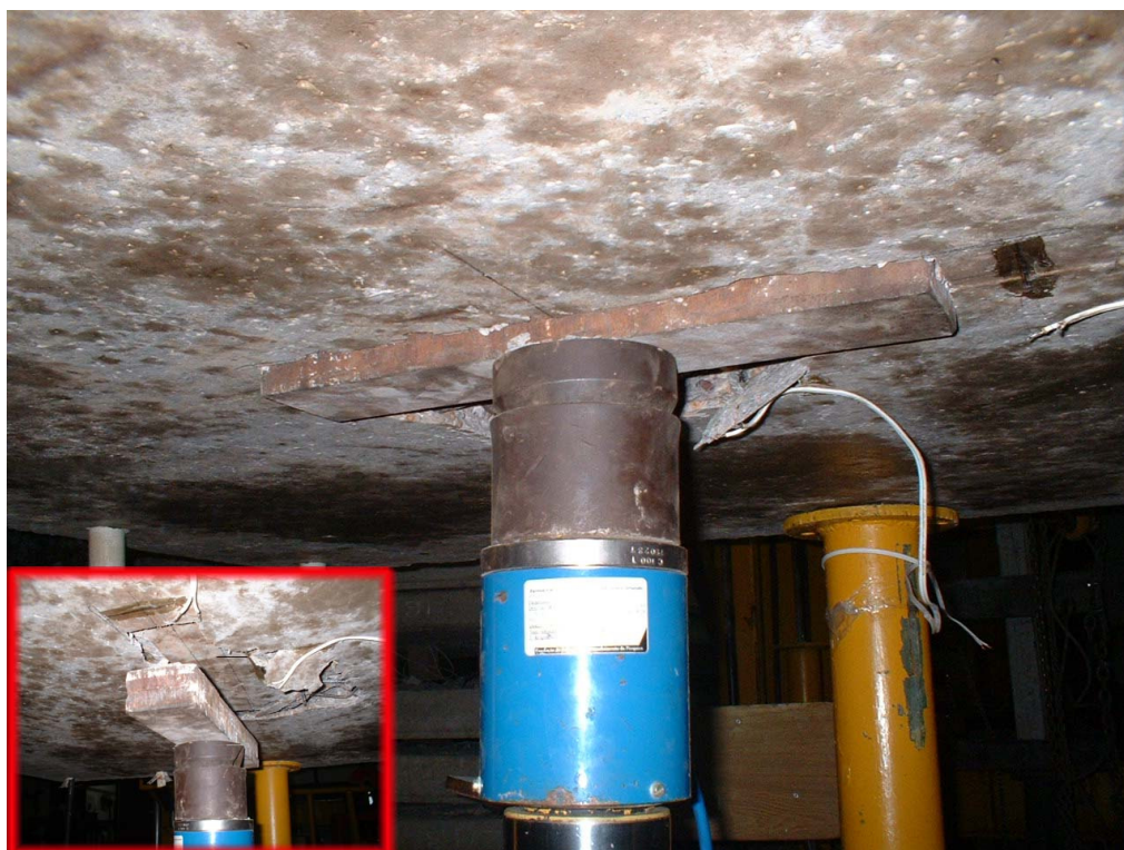
Figura 6.88 - Face inferior da laje L7 após o ensaio
