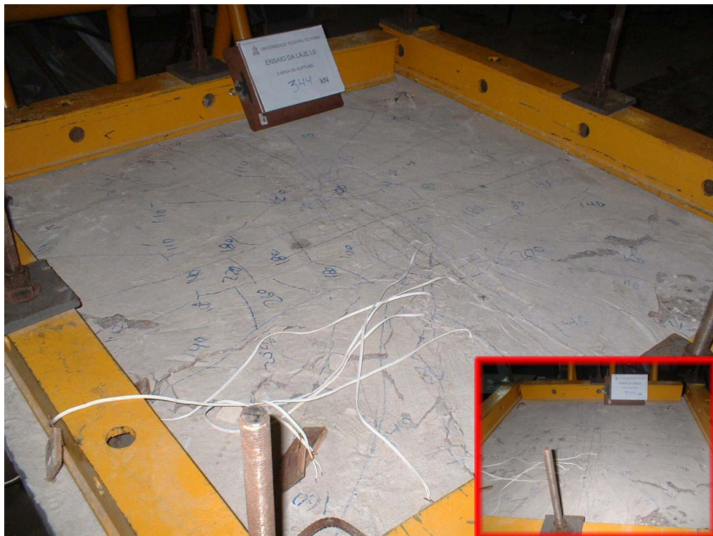
Figura 6.68 - Fissuras desenvolvidas na face superior da laje L6
