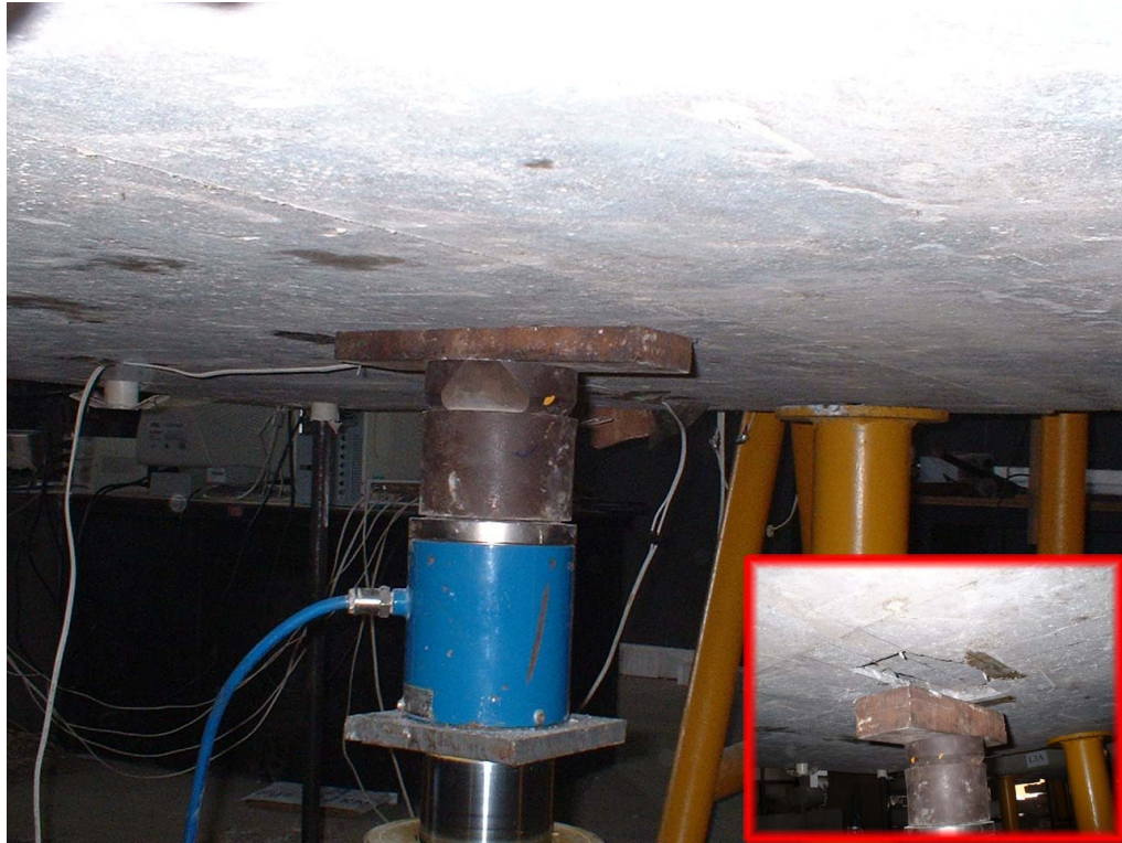
Figura 6.78 - Face inferior da laje L2 após o ensaio
