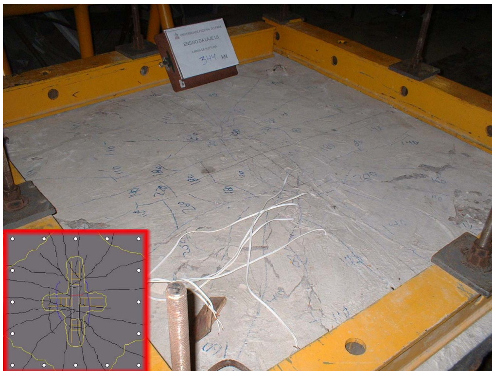
Figura 6.85 - Face superior da laje L6 após o ensaio
