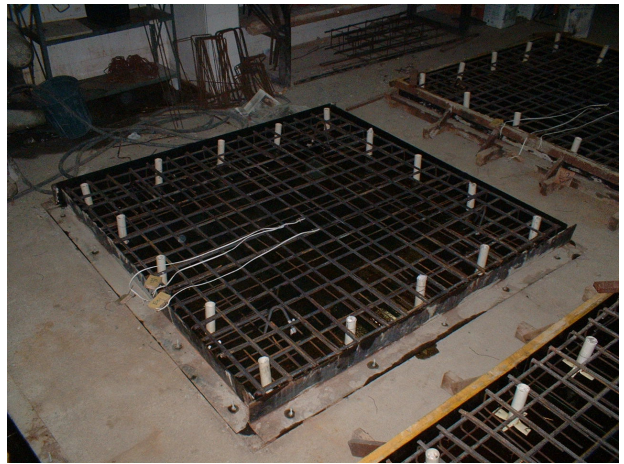
Figura 8 - Armaduras na fôrma
